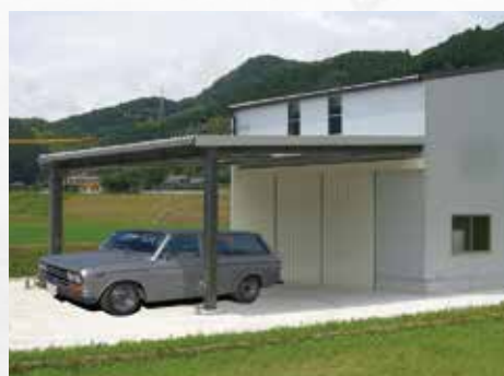
大型機械整備工場
