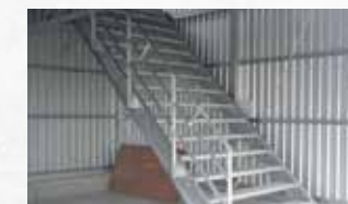
手摺付鉄骨階段
